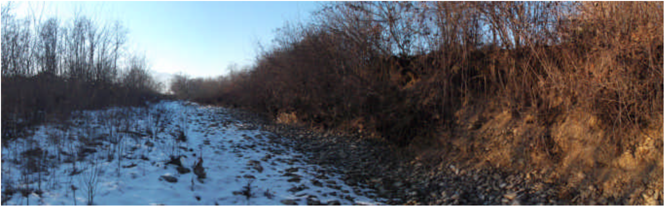
FIGURA 3: VISTA VERSO MONTE DELL'AREA CON EROSIONE IN SPONDA SINISTRA (DESTRA NELLA FOTO).
